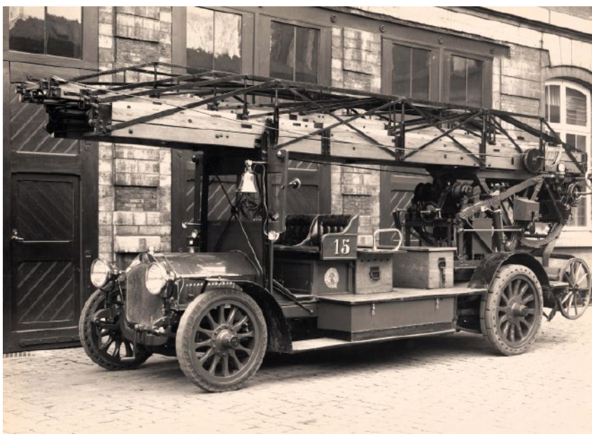
Houten mechanische autoladder van Magirus van 30 meter voor de Brusselse brandweer op een Saurer-chassis uit 1913. Dit is de eerste ladder van 30 meter die door de Belgische brandweer werd gebruikt.
